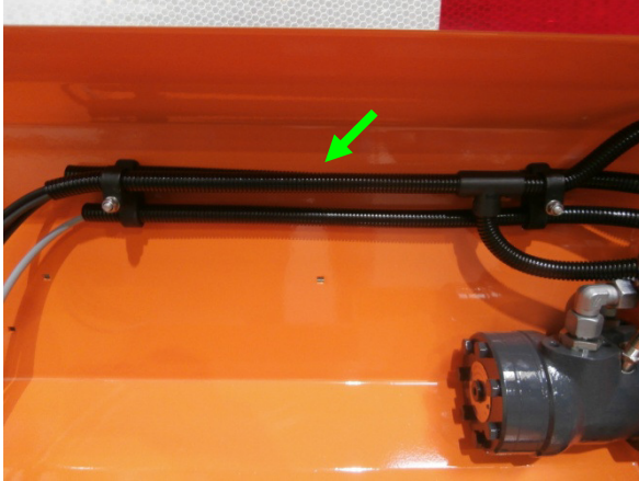
Abb. 6 Kabeldurchführung und Befestigung mit Doppelrohrschellen
